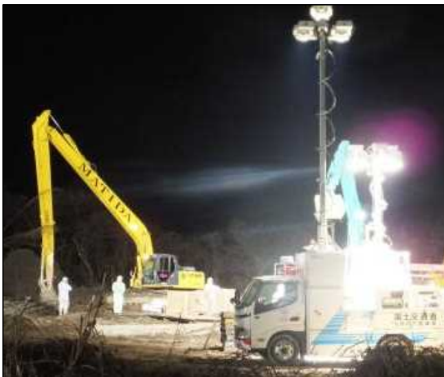
埋却箇所の照明支援(上越市)
