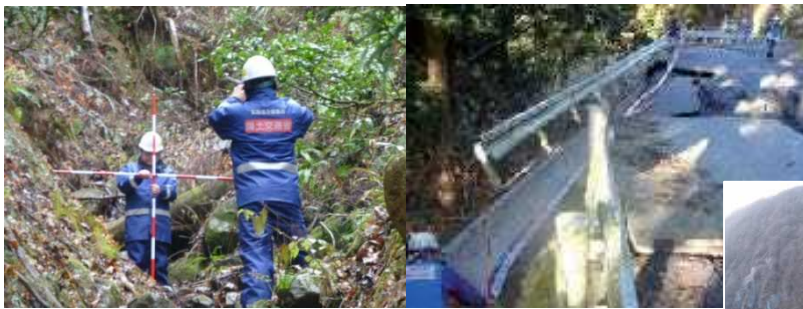
管理施設の被害状況の調査
